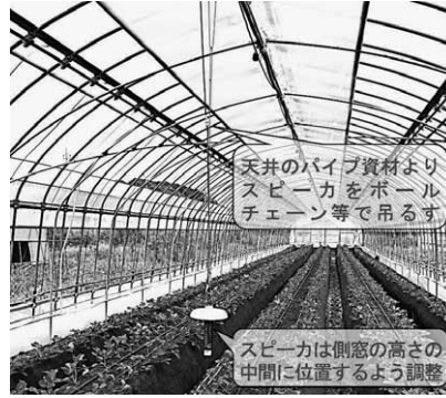
パイプ資材より吊り下げたスピーカ
