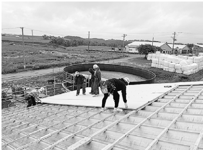
断熱パネルの設置の様子
