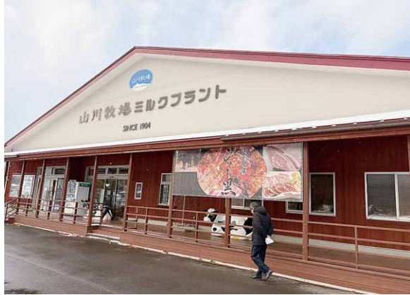
山川牧場ミルクプラントの外観
