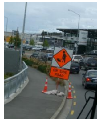
道路はどこも工事中
